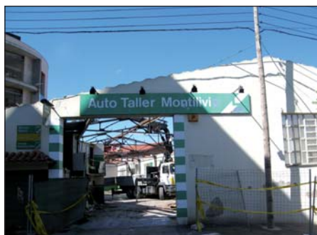
Demolició 2 de juny 2007
