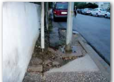
Obres al c/ Palau i Quer, 17 de setembre de 2010
