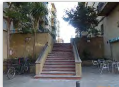
Caldria eliminar aquesta barrera arquitectònica i construir una rampa.
