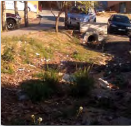
Canalitzar els desguassos de la Punta del Pi i Muntanya
