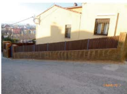
3) Farem el seguiment de la pavimentació del tram del c. Castellet i Turó Rodó.
