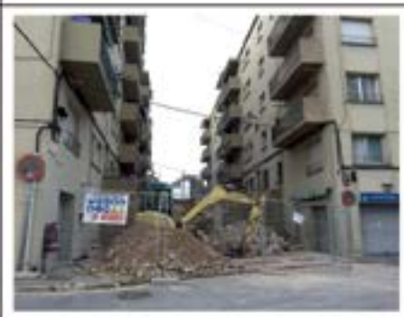
2015_09_12 Inici obres ascensor Punta del Pi.
