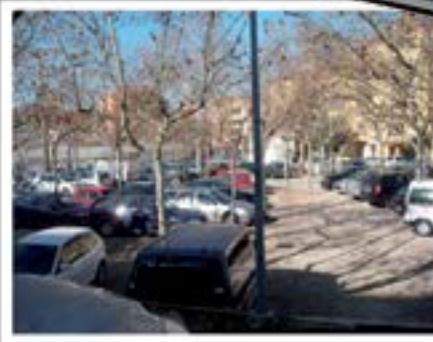
2015_12_10 Inici obres asfaltat de l'aparcament petanca.
