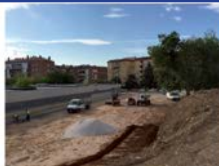
2015_05_31 Obres de l'aparcament del CAP. Una realitat.
